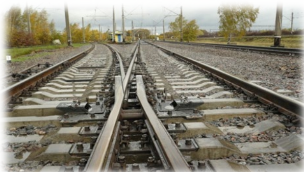
Рисунок – 5 Крестовины с подвижным сердечником на СП
