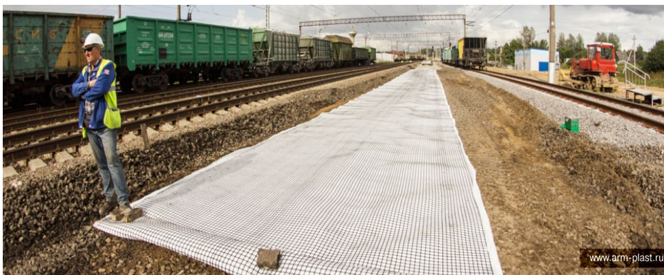
Рисунок 1 – Укладка геотекстиля
